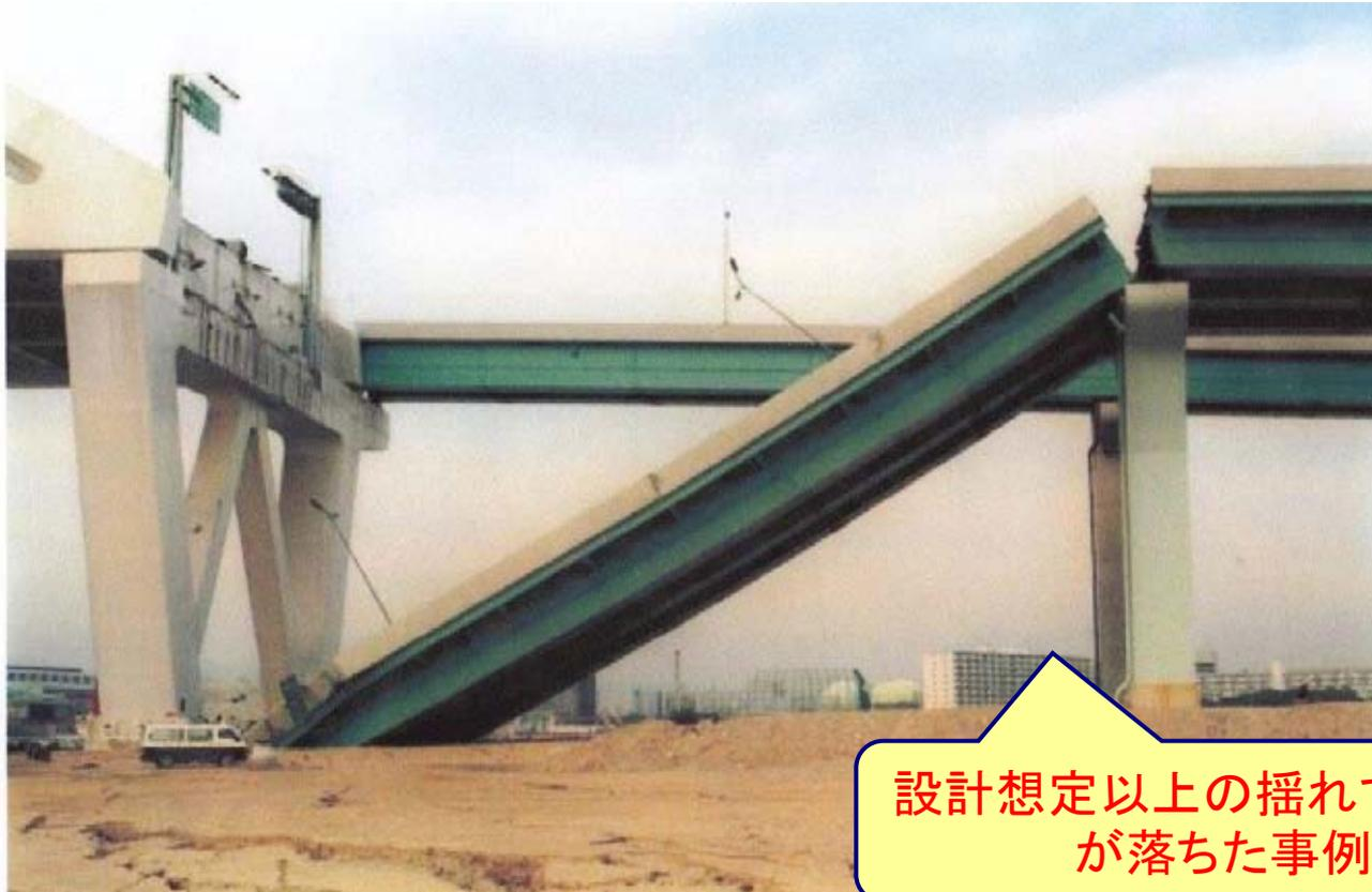
橋げたが、数十センチ水平移動して落橋した。
