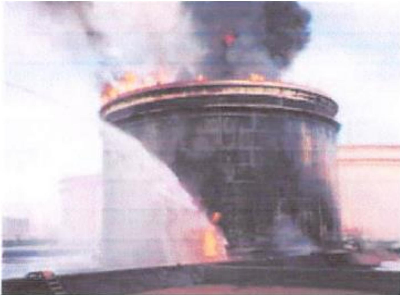
2003年9月北海道十勝沖地震(M8.0)で、200kmも離れた苫小牧でスロッシングにより火災・崩壊した3万KLナフサタンク。
